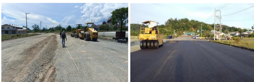
Gambar 3.4.1 Peningkatan Jalan Pasar Rakyat
