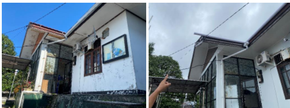
Gambar 3.5.1 Pemeliharaan Gedung Pemerintah di Wilayah Kecamatan Tarakan Timur
