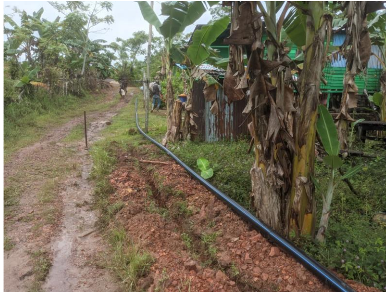
Gambar 3.1.1 Pemasangan Jaringan Distribusi Air Minum Kelurahan Pantai Amal
