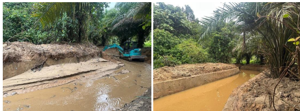
Gambar 3.2.2 Sebelum dan sesudah pemeliharaan saluran Karang Anyar
