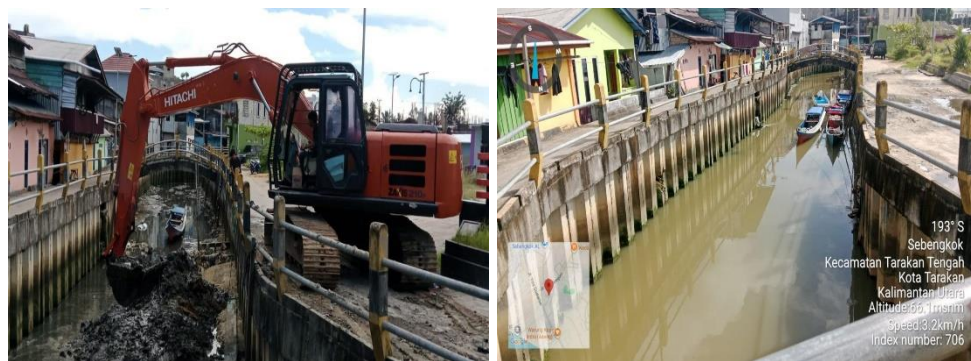
Gambar 3.2.1 Sebelum dan sesudah pemeliharaan saluran Sebangkok
