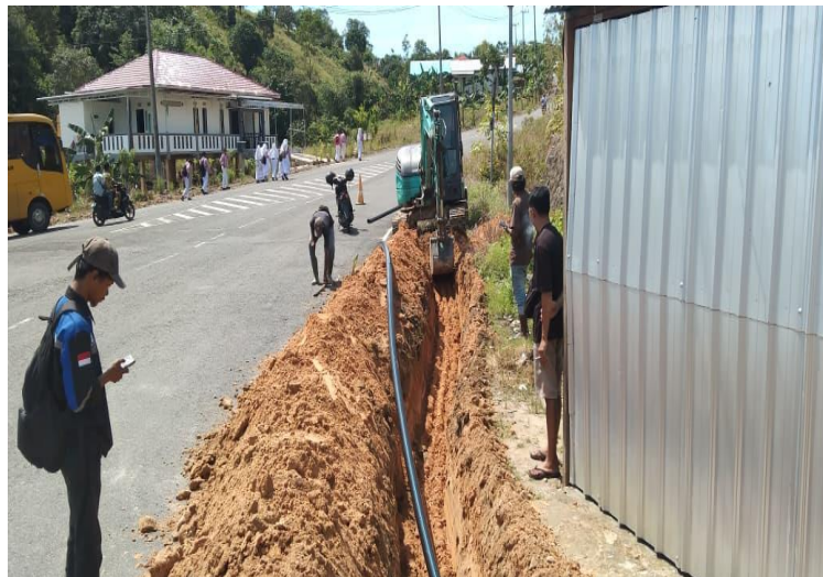
Gambar 3.1.2 Pemasangan Jaringan Distribusi Air Minum Kelurahan Mamburungan
